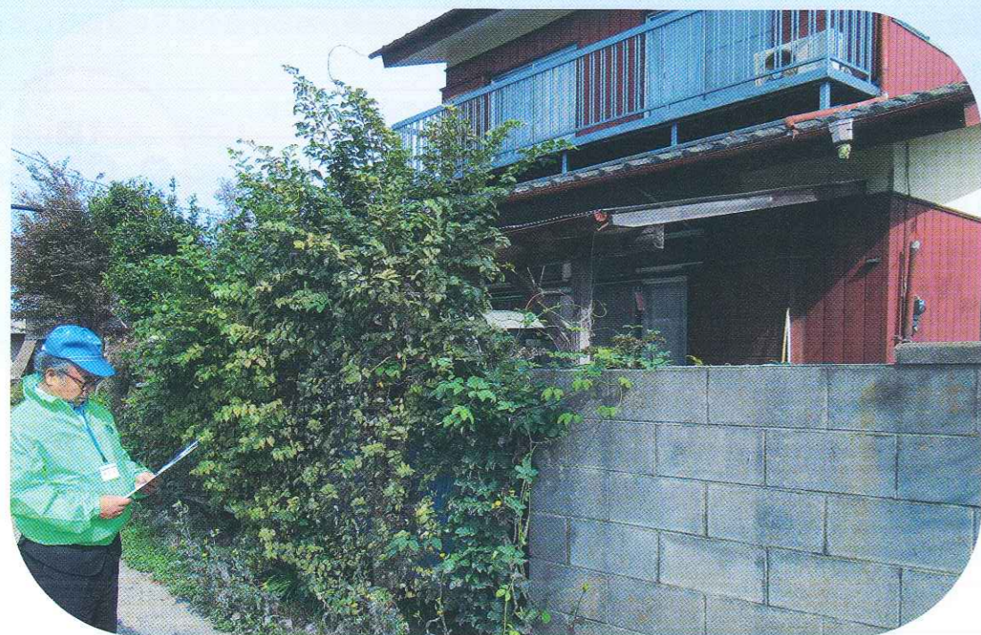
チェックシートによる(雨どいの壊れ)確認
